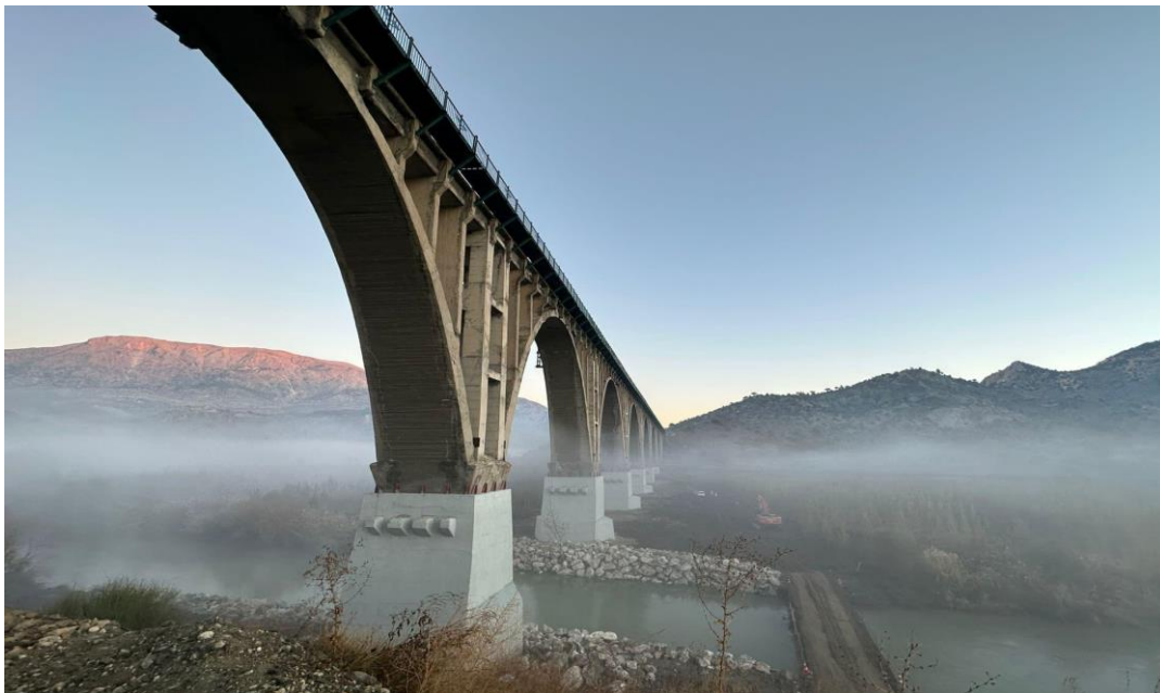
Onarılan Demiryolu Köprüsü (Alman Köprüsü), Adıyaman
