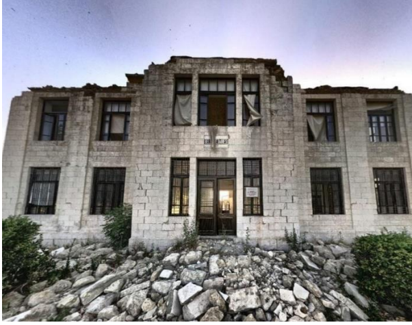
Hatay Belediye Binası
