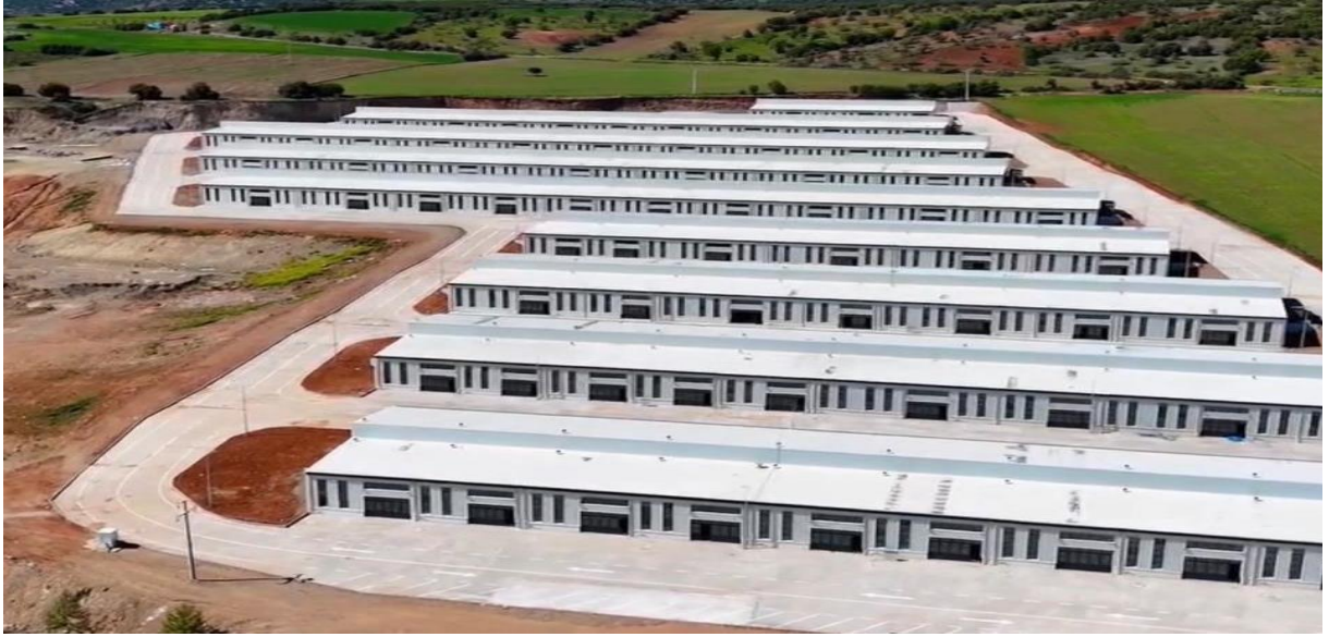
Kahramanmaraş Pazarcık'ta İnşa Edilen İşyerleri
